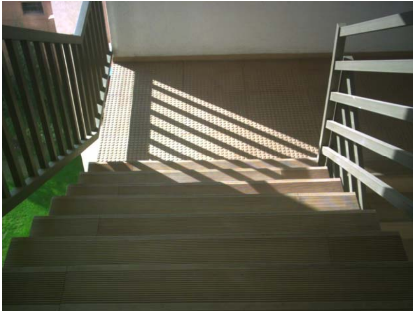
Interior Zona Vertical de Seguridad
