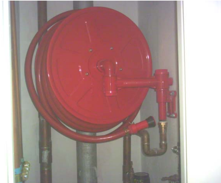
Red Húmeda del edificio
