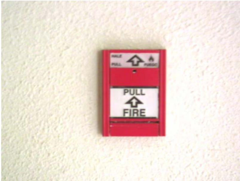
Palancas de Incendio
