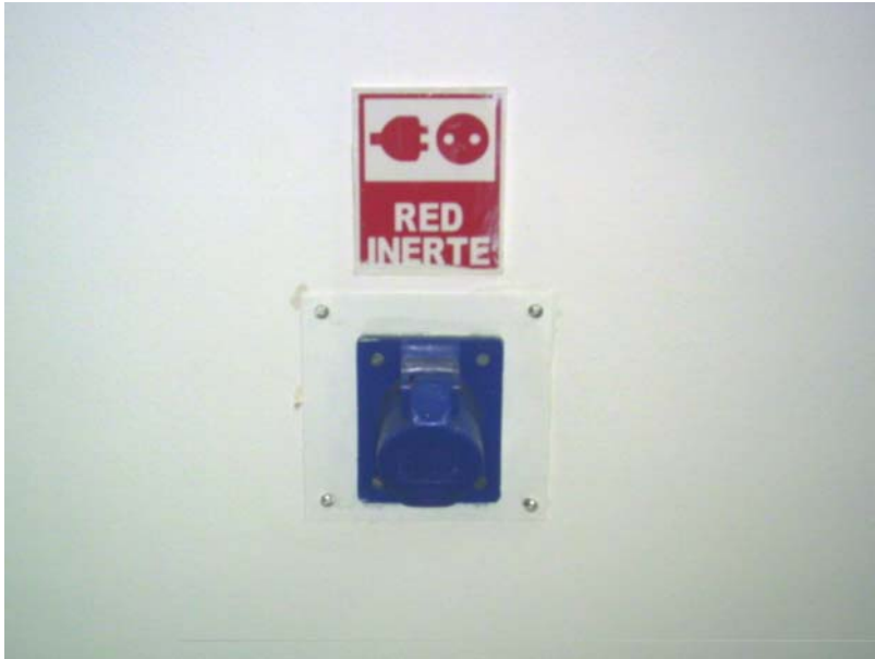
Salida Red Inerte por piso
