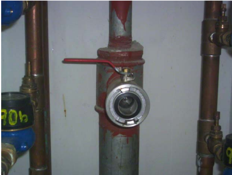
Salida de Red Seca por piso
